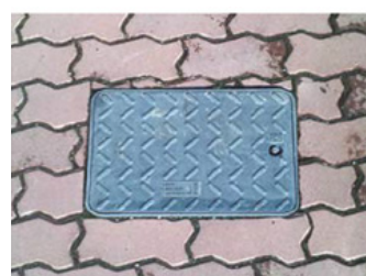
Pojezdový poklop - nosnost 12,5 t
